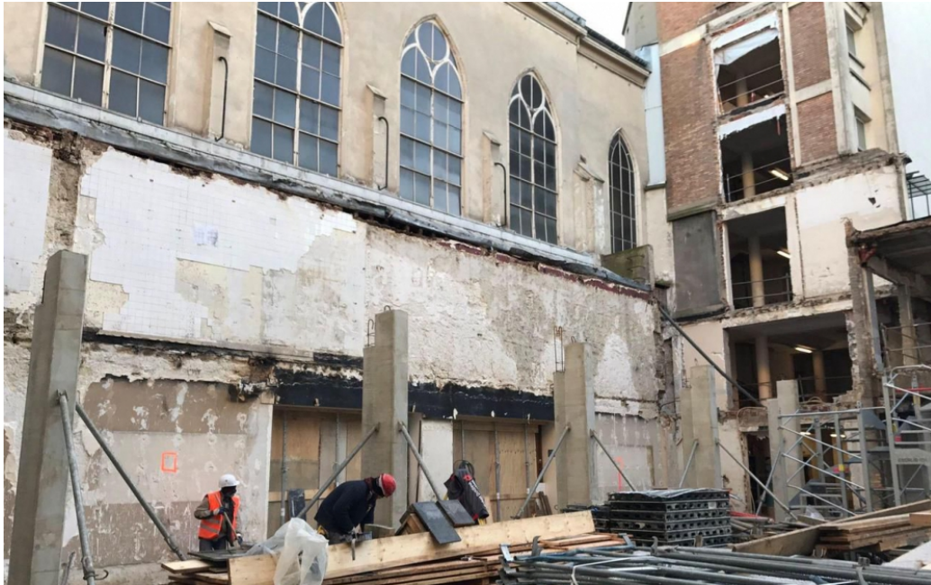
Le chantier de reconversion en logements sociaux des bureaux de l'ancien siège social de l'INPI situé à l'angle des rues de Saint-Pétersbourg et d'Amsterdam a démarré. LP/C.H.
