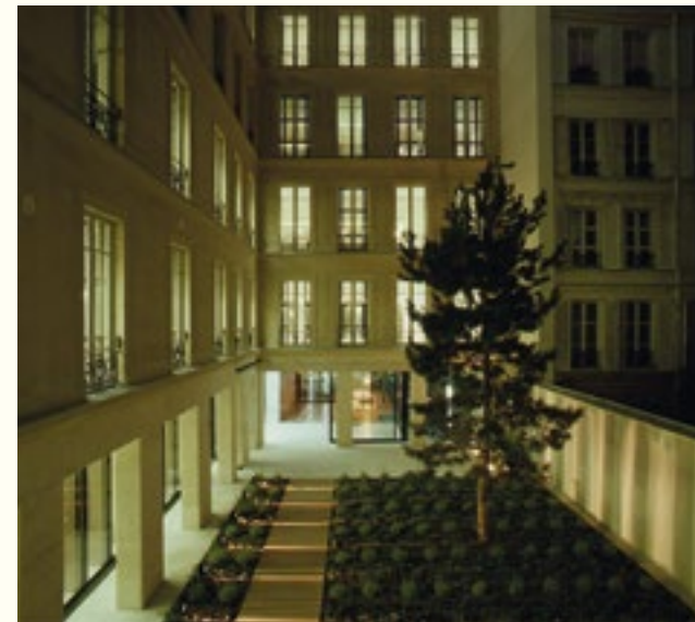
Bureaux rue de Surène, Paris VIII e arrondissement, 1997. Le projet comprend la restructuration lourde d'un immeuble de 2 800 m 2 , ainsi que l'aménagement des espaces intérieurs, l'ouverture de baies en rez-de-chaussée et la création d'un jardin. Office building, Paris 8th arrondissement, 1997. The project includes the heavy renovation of a 2,800-sq.m building, as well as the interior design, the opening of bays on the ground floor and the creation of a garden.
